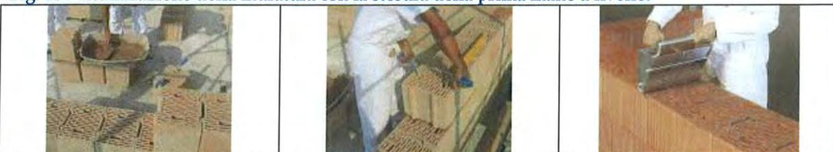
Fig. 4c - Posa in opera del giunto orizzontale con la tecnica per immersione o per mezzo del rullo.
