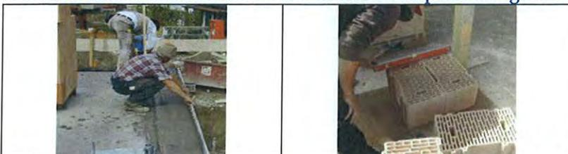
Fig. 4b - Realizzazione della muratura con la stesura della prima mano a livello.
