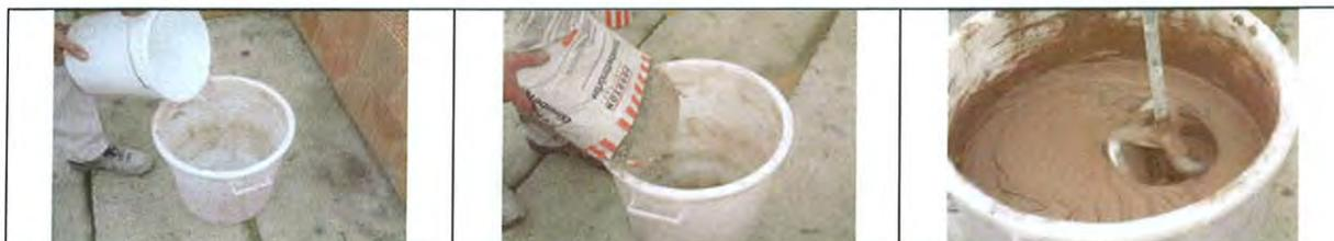
Fig. 4a - Preparazione della malta premiscelata, a cui vengono aggiunti circa 10 litri di acqua; successivamente mescolata fino ad ottenere un impasto omogeneo.
